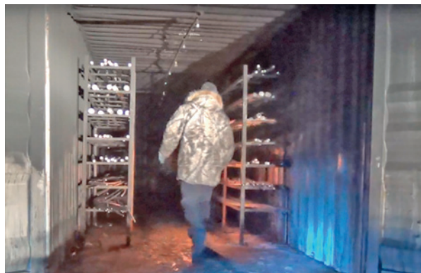
Фрагмент «кабельного сооружения»
